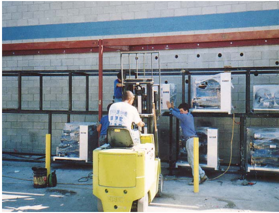
Figure 228A Rack을 짜서 콘덴싱 유니트를 올리는 작업. 1992년 필자가 Los Angeles 에 Advance Market 설계하고 설치 작업.
